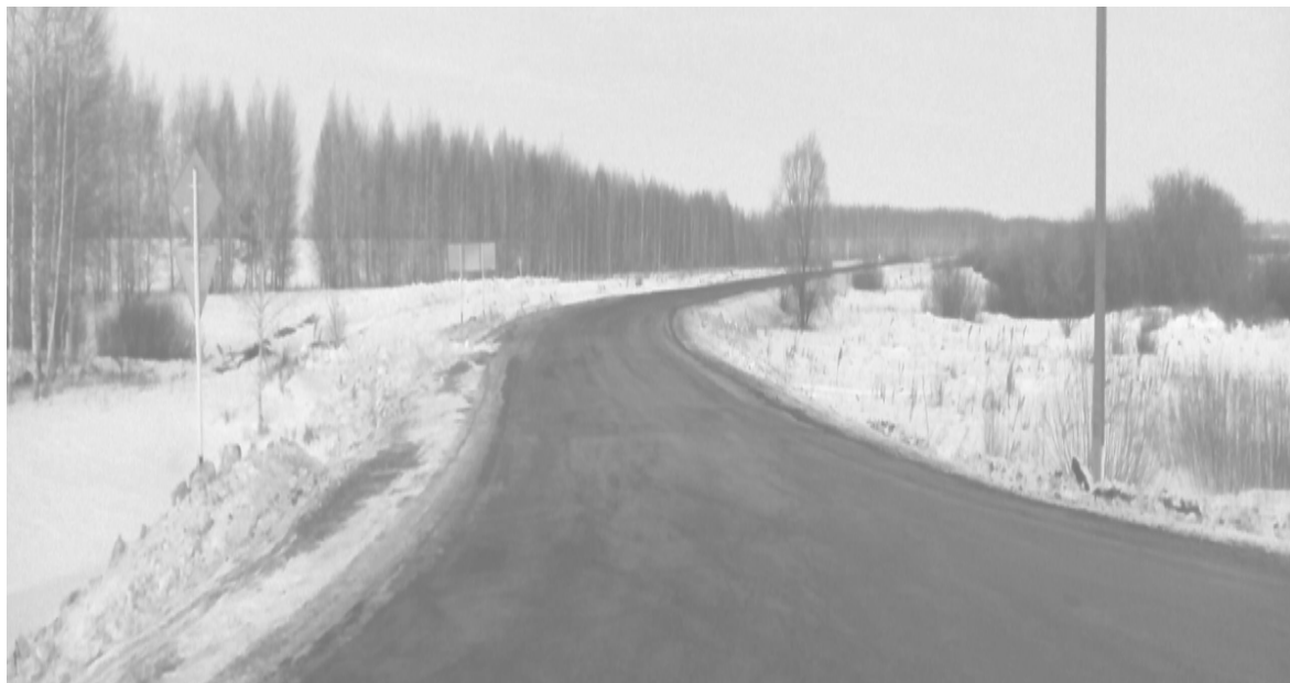
Обводная дорога села Челно-Вершины была построена в 90-х годах прошлого века. Её строительство было проведено Челно-Вершинским ДРСУ.
